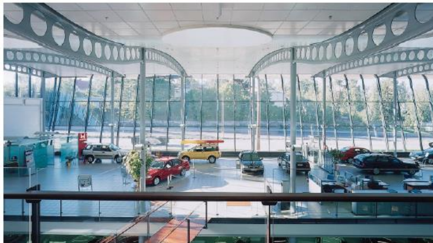
Figura 4 – Aspecto estético das vigas celulares, que conferem um grande apelo arquitetônico. Fonte: http://www.asdwestok.co.uk/ - acessado em: 13 Agosto, 2015.
