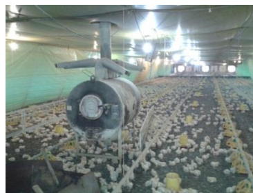
Figura 3. Foto de um forno a lenha, em um aviário convencional.
