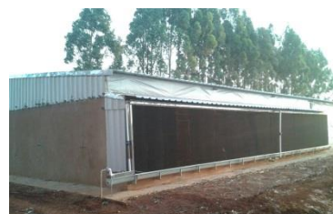
Figura 6. Foto da placa evaporativa na extremidade do aviário Dark – House, com cortina.
